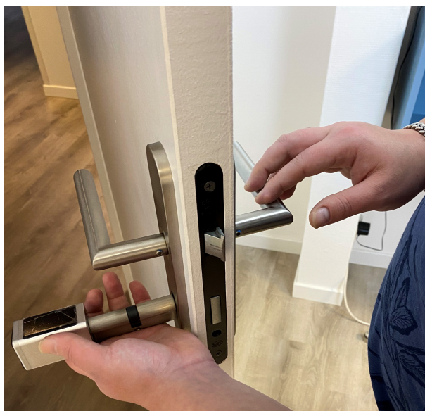
Sans forcer , glisser le cylindre dans l'emplacement de la porte
