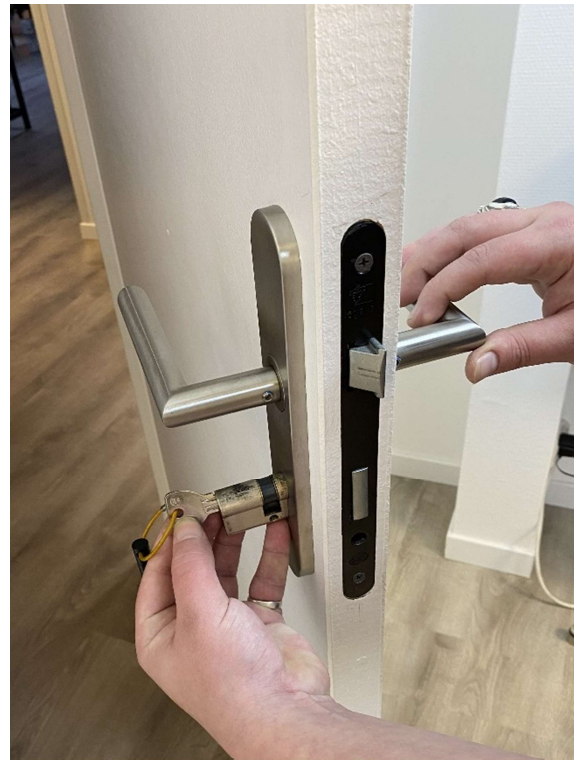
A l'aide de la clé du cylindre retirer le cylindre
