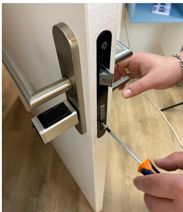
Mettre en place la vis afin maintenir le cylindre
