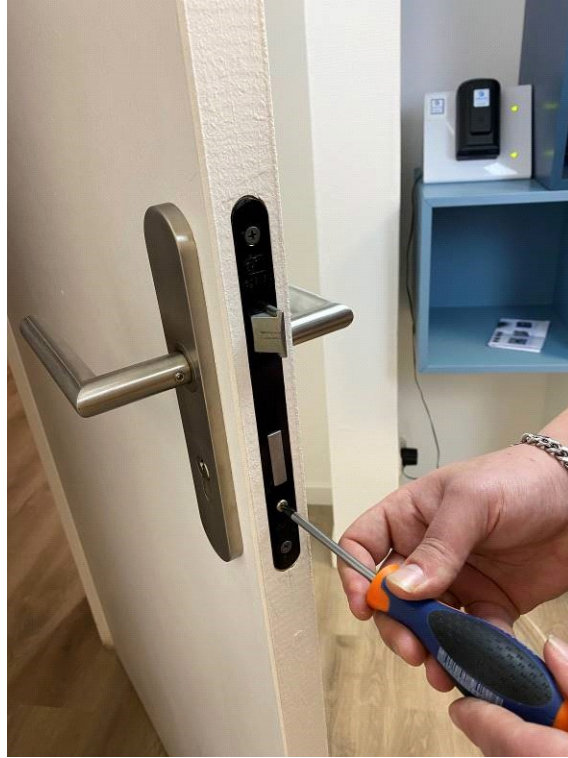
Dévisser la vis maintenant le cylindre
