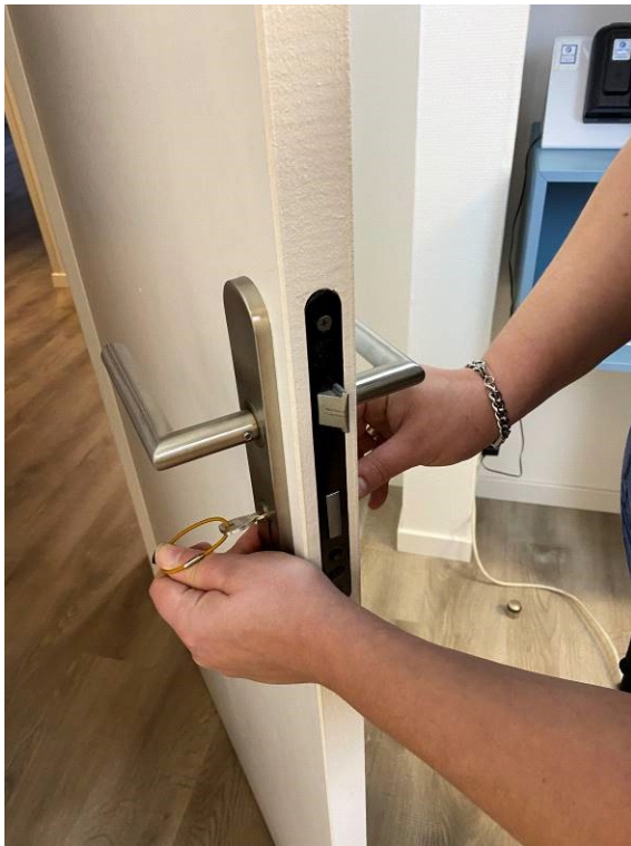
A l'aide de la clé du cylindre retirer le cylindre
