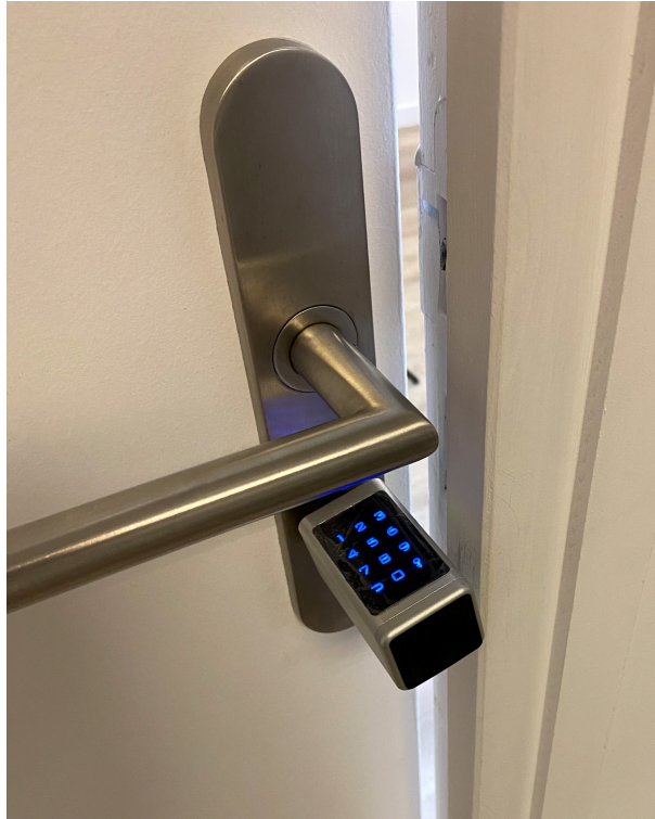
Vérifier que le cylindre ne touche pas le mont de la porte
